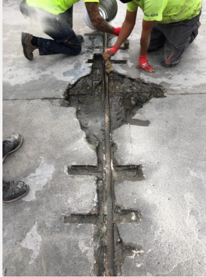
1) Imprimación de Zoruflex R700 aplicado a brocha a modo imprimación
