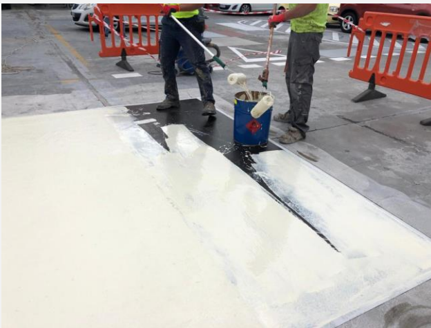
1) Aplicación de la primera capa de Zoruflex R33
