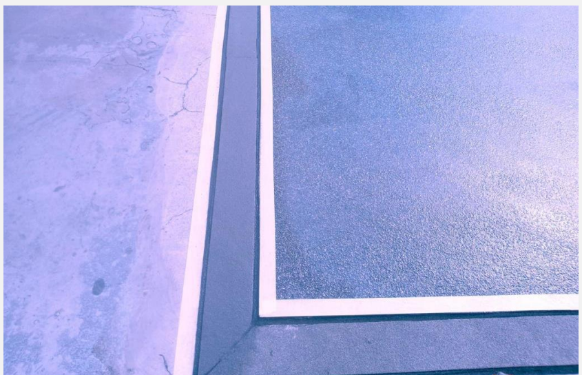
2) Colocación de las plaquetas preformadas sobre Zoruflex R1
